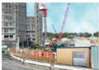
●工事現場での仮設事務所
