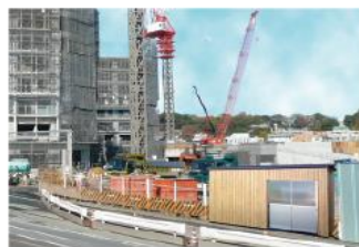
●工事現場での仮設事務所
