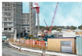
●工事現場での仮設事務所
