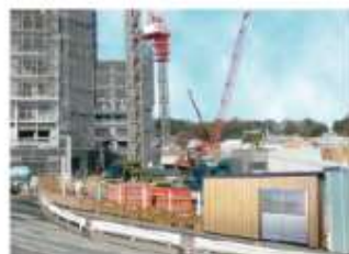
●工事現場での仮設事務所
