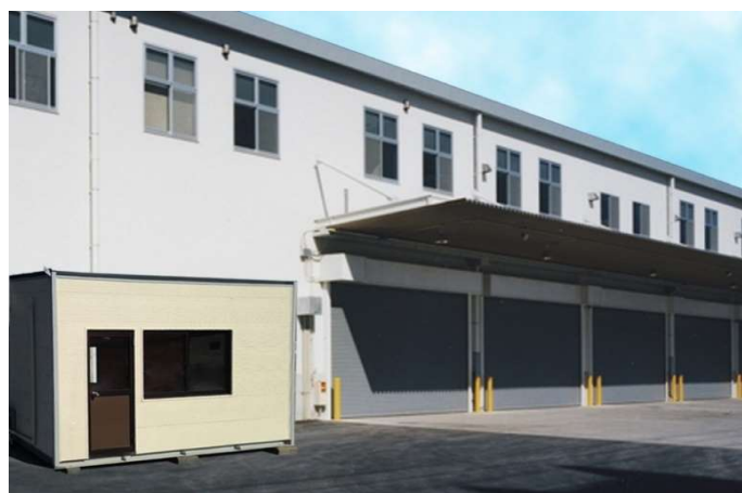
●倉庫敷地内での休憩室・管理室
